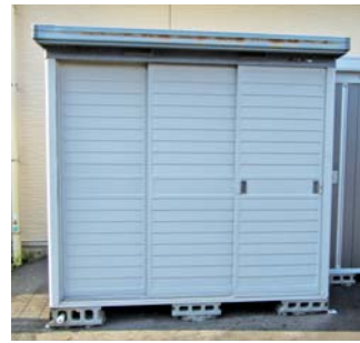
コンクリートブロックなどを四隅に置いて、その上に設置してあるもの
