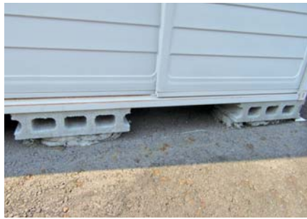
コンクリートブロックなどを四隅に置いて、その上に設置してあるもの
