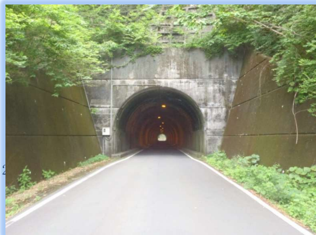
白浦トンネル
