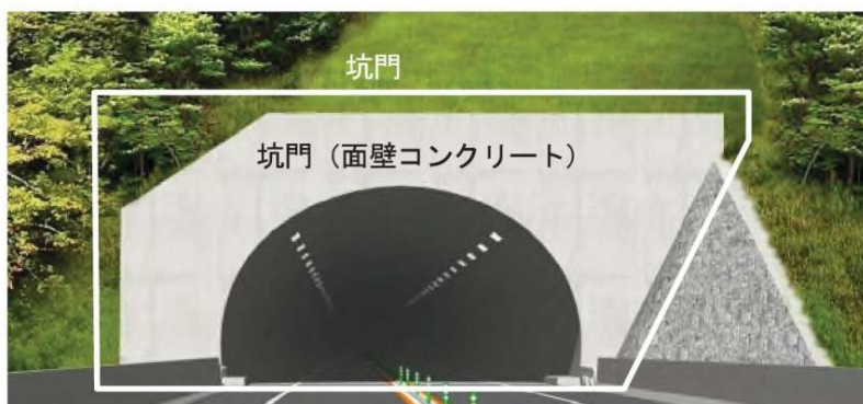
図-1.2 点検対象箇所(トンネル坑口部)
