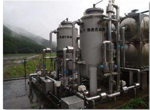
図 2-13 十須浄水場（急速ろ過機）
