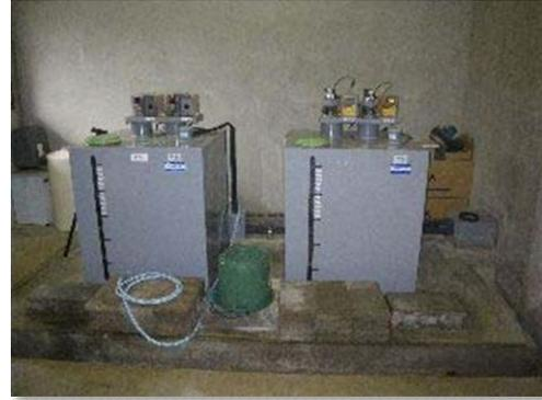
図 2-7 紅ヶ平浄水場（塩素注入機）
