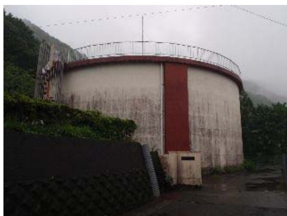
写真 2-10 沖見低区配水池
