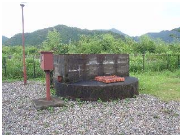
写真 2-1 紅ヶ平第 1 号水源取水井
