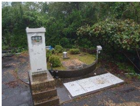
写真 2-2 便ノ山取水井
