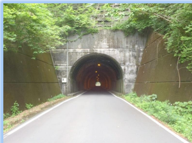
白浦トンネル
