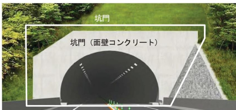
図-1.2 点検対象箇所(トンネル坑口部)
