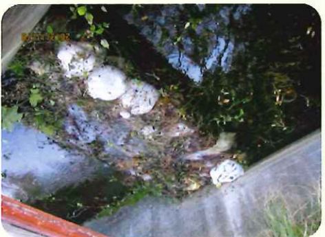
土のりによる洪水吐のかさ上げ
