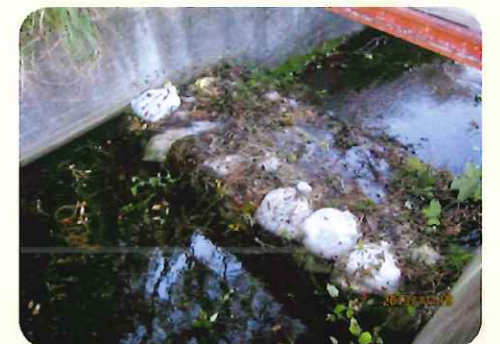
土のうによる洪水吐のかさ上げ
