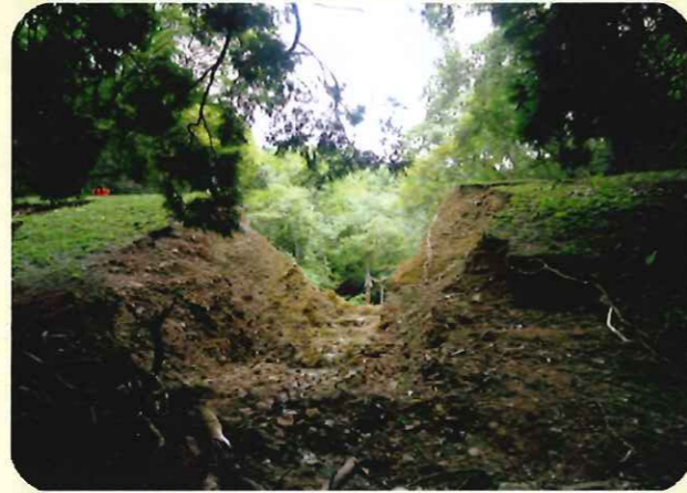
大雨により決壊したため池
